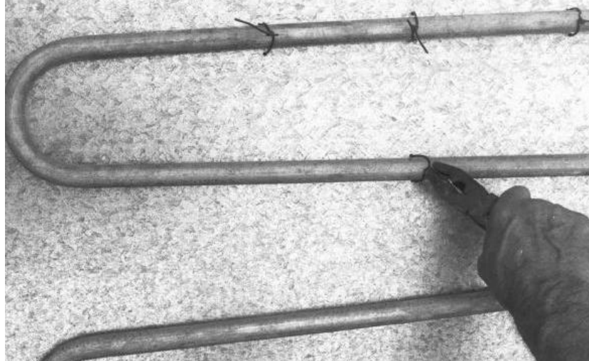
Tubo del absorbedor juntado a la plancha con alambre
