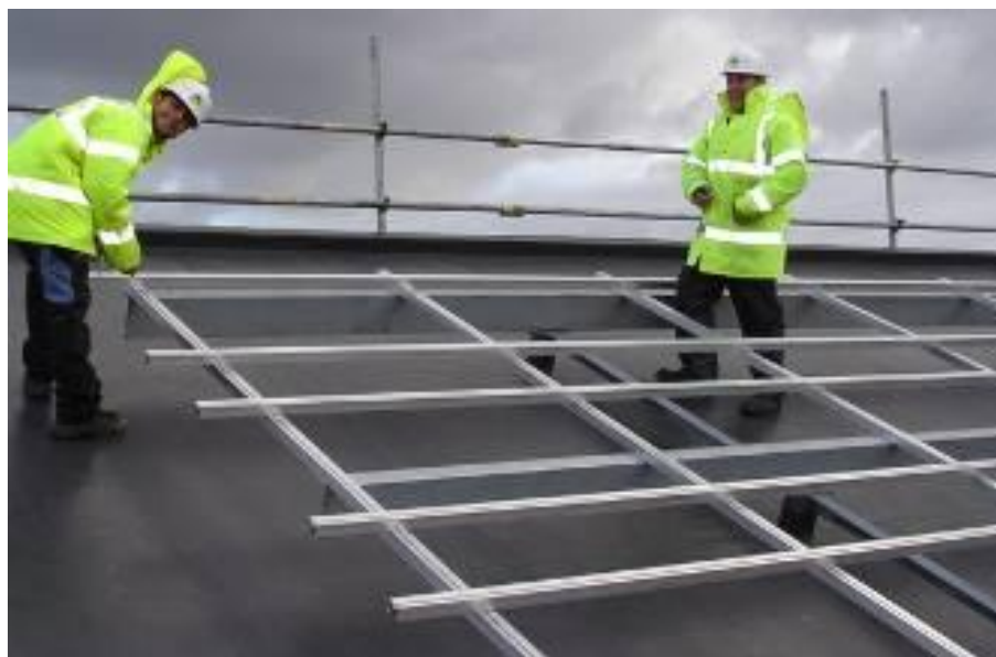
Instalación Solar en Cheshire, UK: no la solución para Guatemala
